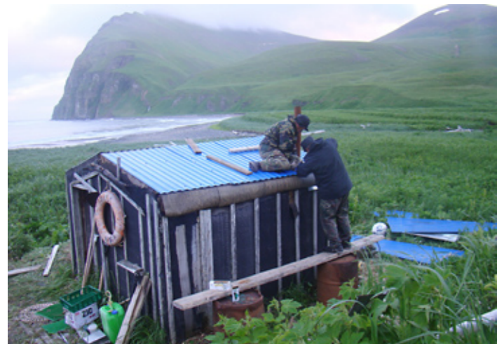
Ремонт в б. Перегребная
